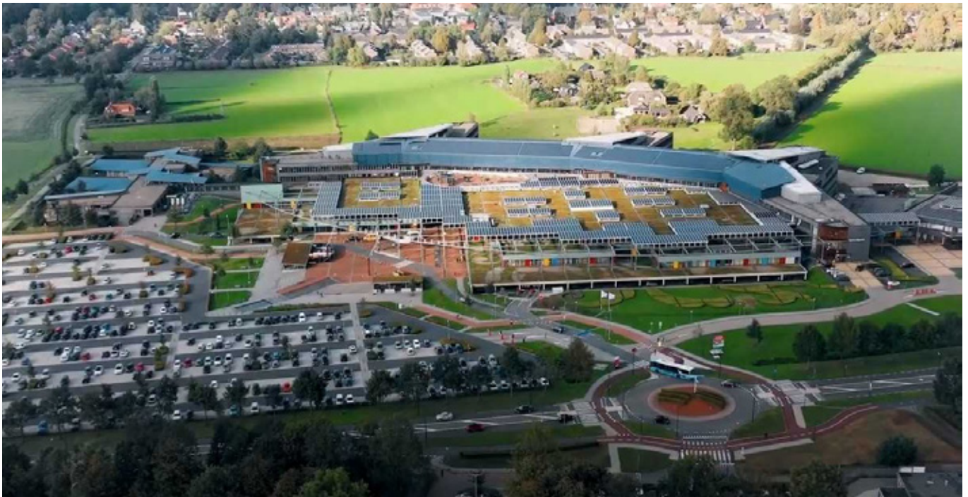
Luchtfoto Deventer ziekenhuis
